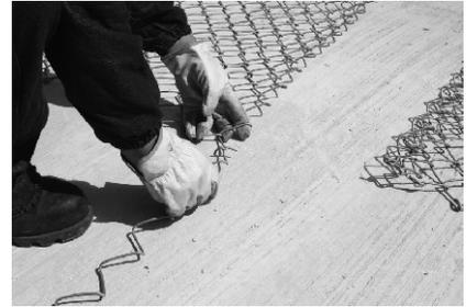
2. Suelte el alambre en espiral del extremo del rollo.
