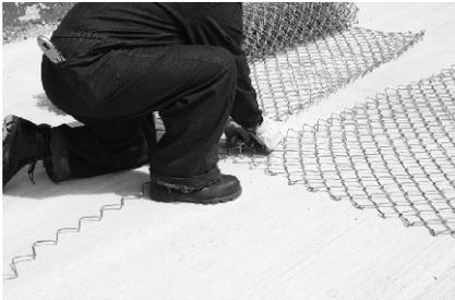
3. Acerque los dos extremos de los rollos y entrelácelos con el alambre en espiral.
